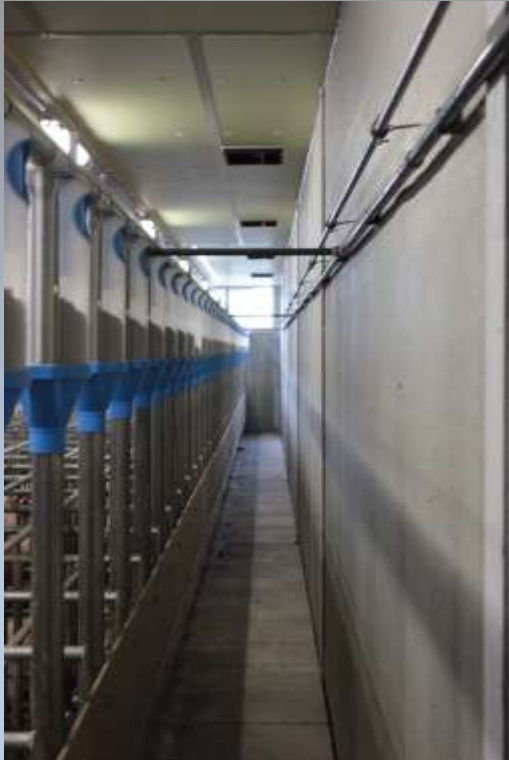
Figuur 5 Controlegang met openingen (tegen de muur)
