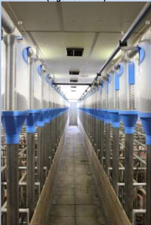
Figuur 6 Controlegang met openingen (in het midden van de afdeling)
