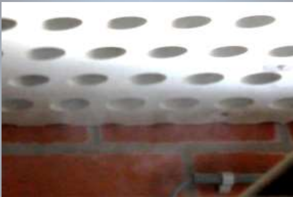
Figuur 10 De rookproef toont een homogene verdeling van de lucht
