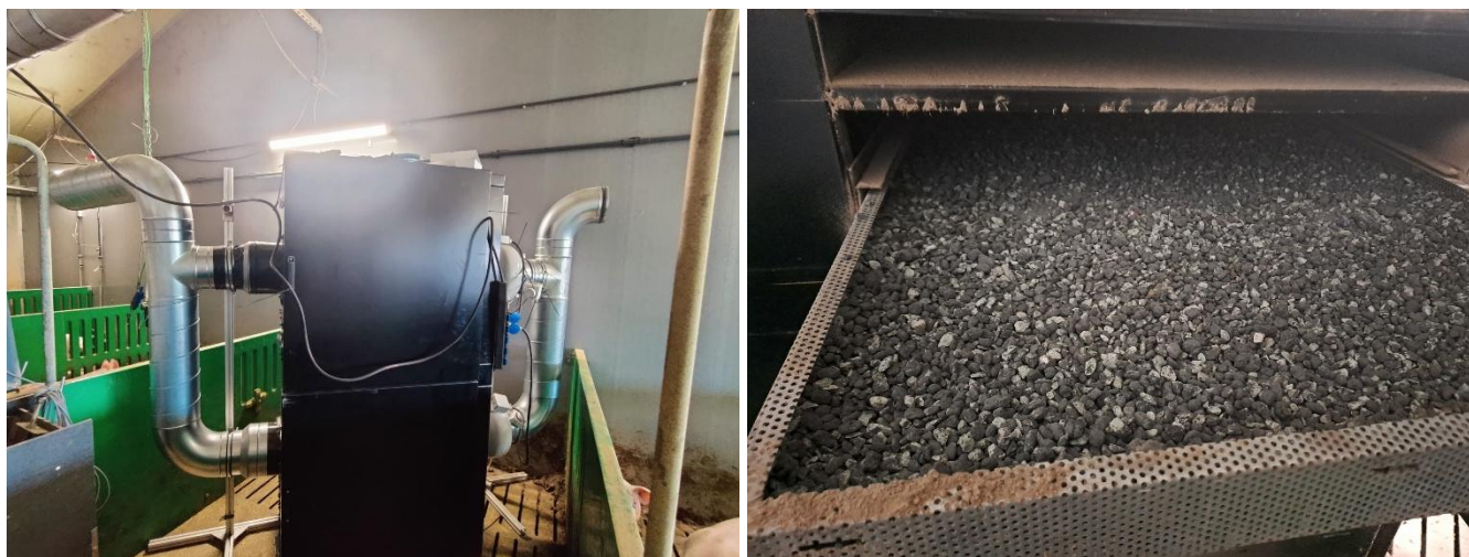
Figuur 2. Illustratie van de filterbox geïnstalleerd in de varkensafdeling (links) en een foto van één van de gevulde cassettes (rechts).
