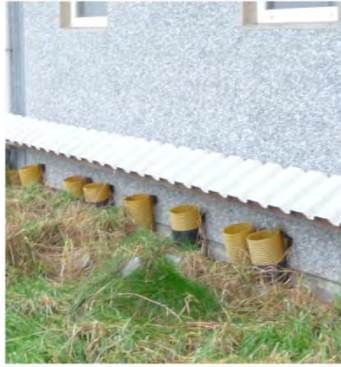
Figuur 49: Reinigingsopeningen van een rioleringsysteem.
