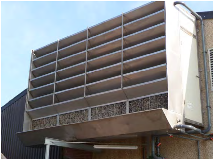
Figuur 14: Buitenconstructie van een luchtwasser.
