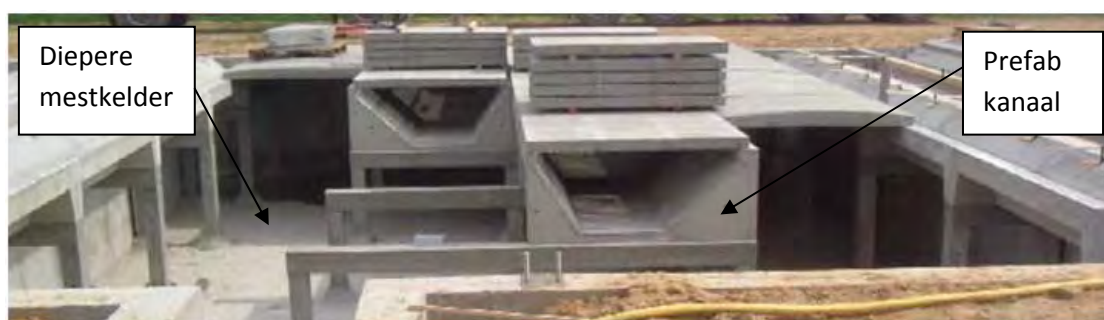
Figuur 3: Prefab kanalen.
