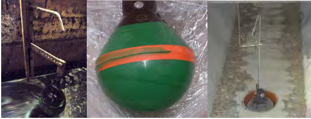
Figuur 43: Bolafsluiter en bevestigingssysteem.
