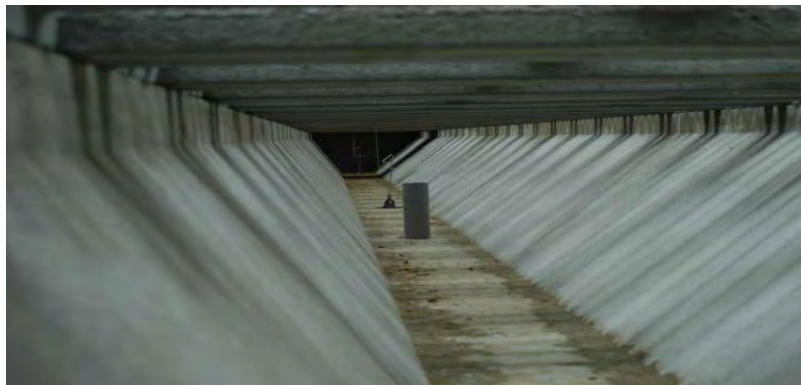
Figuur 51: Overloop in een mestkanaal.
