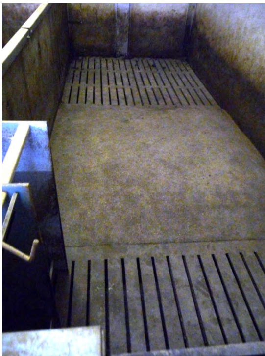
Figuur 6: Bolle vloer.
