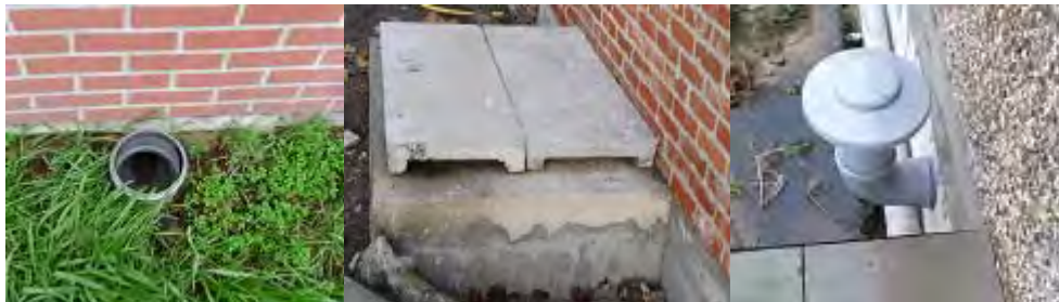
Figuur 57: Ontluchtingsmogelijkheden bij een mestkelder.
