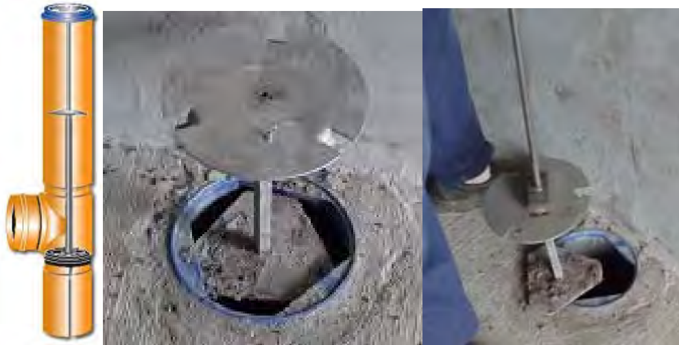
Figuur 45: Afsluitende rubber in een buis.
