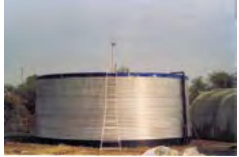
Hemelwateropvang in een metalen silo.
