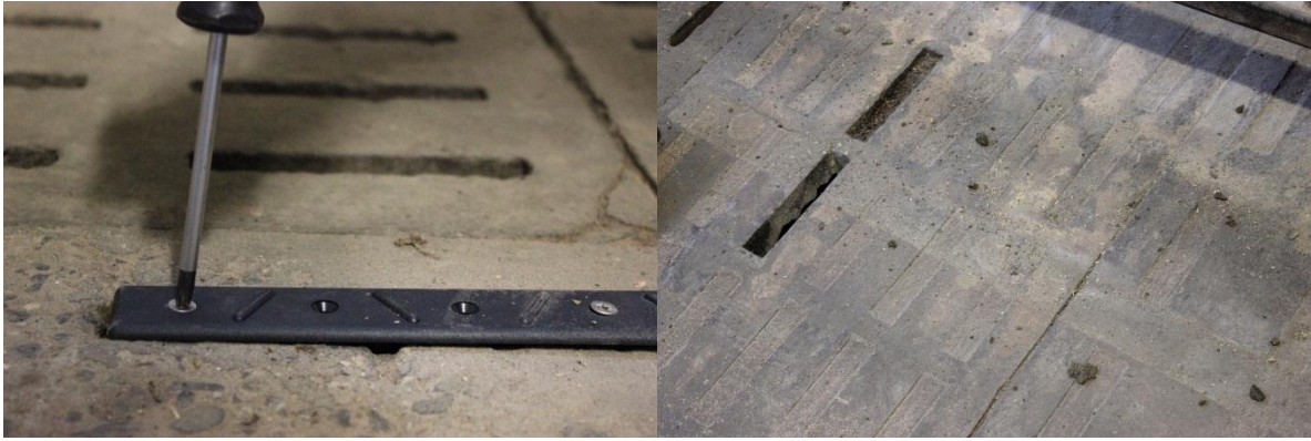
Figuur 2: Omkeerbaar (links) en onomkeerbaar dichtgemaakte roosteropeningen
