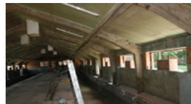
24 mei 2011: aanpassen ramen in functie van ventilatie
