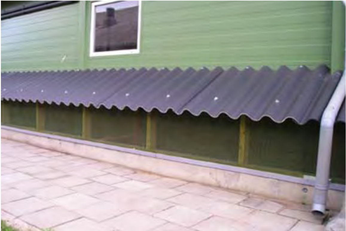
Figuur 35 Luchtinlaat bij kanaalventilatie (bovengronds)
