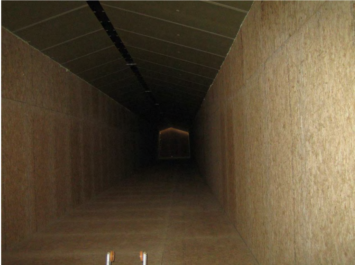
Figuur 39 Centraal afzuigkanaal
