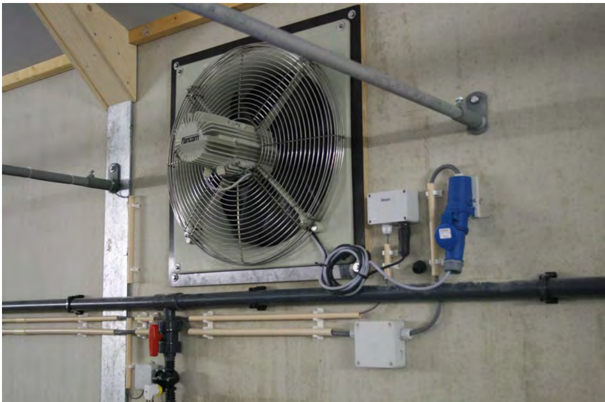
Figuur 44 Mengventilator in de afdelingswand
