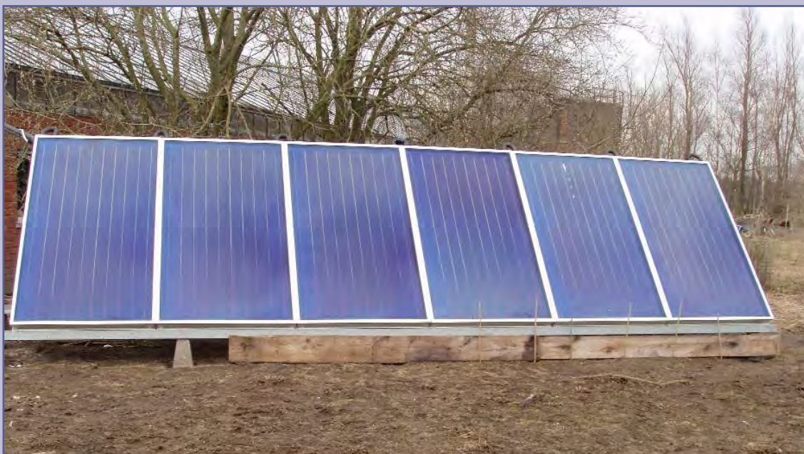
Foto 3: Afzonderlijk geïnstalleerde zonneboiler op serrebedrijf
