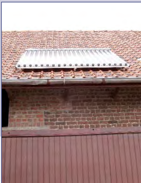
Foto 2: Zonneboiler op melkveebedrijf
