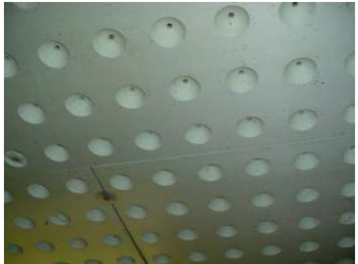
Figuur 3 Plafondventilatie met geperforeerde isolatieplaat
