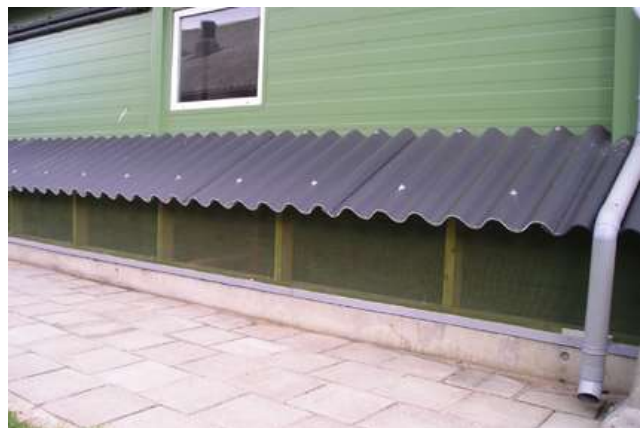
Figuur 3 Luchtinlaat bij kanaalventilatie (bovengronds)
