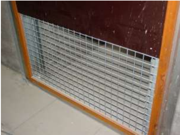
Figuur 4 Deurventilatie met variabele opening
