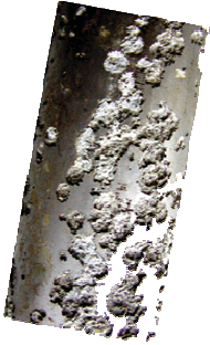
Corrosie, zelfs van roestvrij staal
