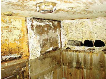
Verkleuring (blauw-groen) van beton tijdens mixen Betonrot doordat bacteriën uit H 2 S zwavelzuur vormen
