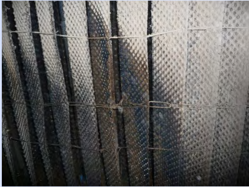
Detail van het waspakket van de luchtwasser (boven) en de ventielopeningen van de plafondventilatie (onder).
